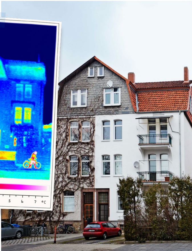
In der Thermografie gut zu erkennen: Bauteile mit einem hohen U-Wert (warme Farben) leiten viel Wärme nach draußen. Bauteile mit einem niedrigen U-Wert (kalte Farben) halten die Wärme im Haus.
